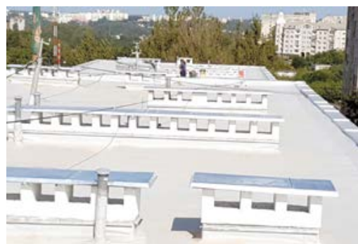
Примеры кровель, выполненных с использованием ПМ
