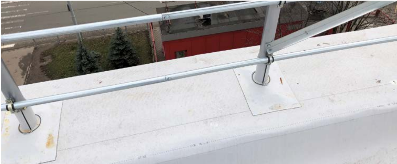
Установка ограждений ТН на парапет
