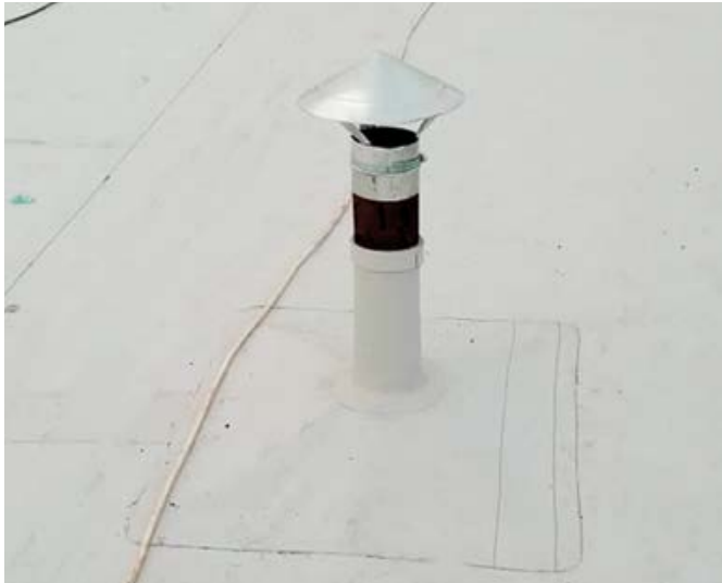
Примыкание к трубным проходкам
