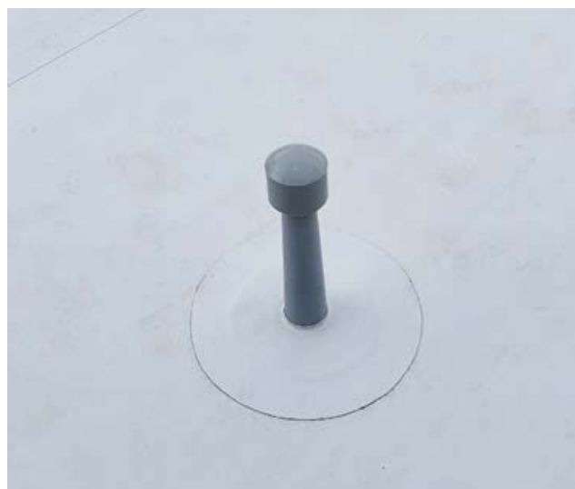
Примыкание к кровельному аэратору
